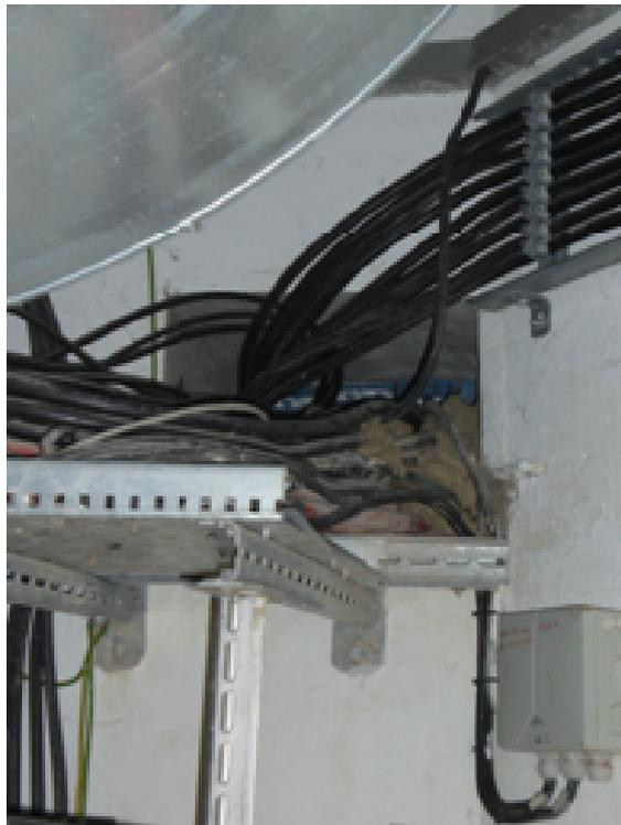
**Abb. 3.15: Kabeleinführung Pumpwerk C (Foto: Graf-van Riesenbeck 2008)**
