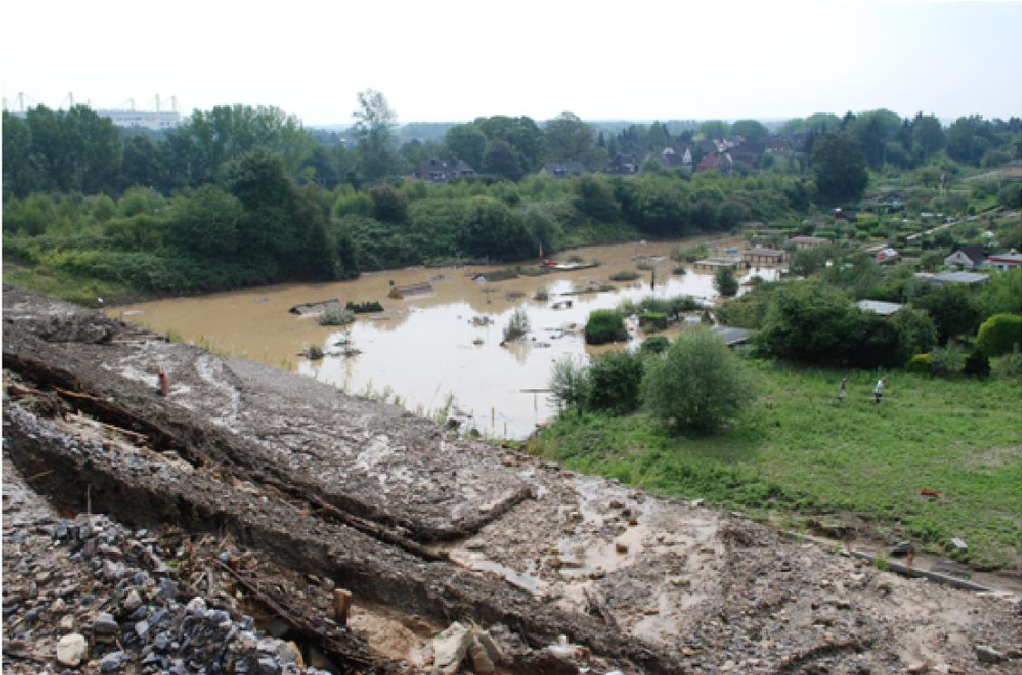
**Abb. 3.2: Abgerutschte B1-Böschung mit überfluteter Kleingartenanlage (Foto: Emschergenossenschaft 2008)**
