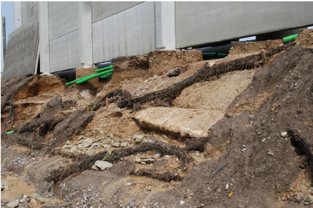
Abb. 3.1: Abgerutschte B1-Böschung mit Lärmschutzwand (Foto: Emschergenossenschaft 2008)
