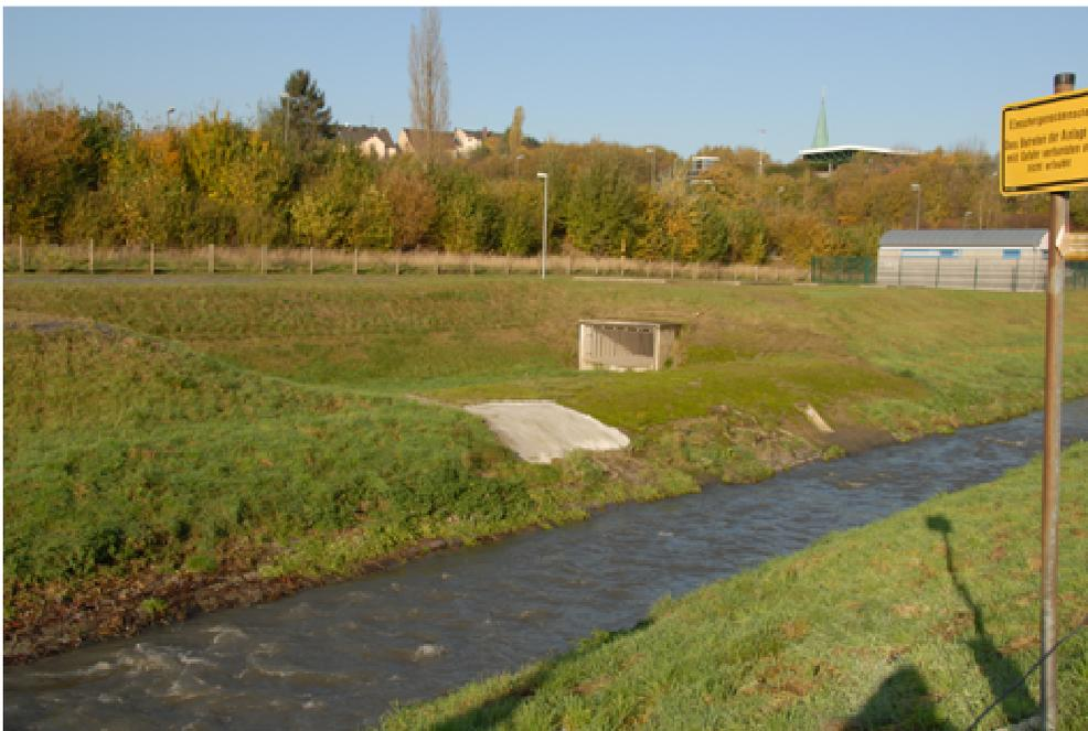
**Abb. 3.9: Einleitungsbereich der Entlastungsanlage des Stauraumkanals (Foto: Wöllecke 2008)**
