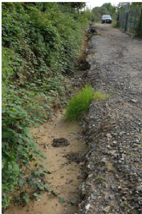
**Abb. 3.3: Zerstörte Versickerungsmulde entlang des Wartungsweges (Foto: Wöllecke 2008)**
