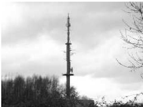
In ca. 2 km Entfernung in Witten-Stockum (hinter dem Edeka) befindet sich ebenfalls ein Sendemast erheblichen Ausmaßes, der in Richtung Südost strahlt. Auch hier sind, neben den Richtfunkantennen, zahlreiche Mobilfunkantennen montiert.
